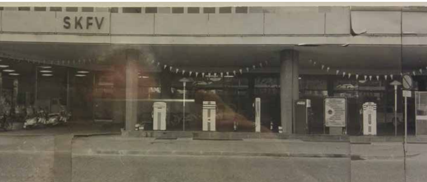
Lato sinistro del fabbricato; sul marciapiede il distributore di benzina. Per gentile concessione del dottor Franz Staffler, Finifi Bolzano.
