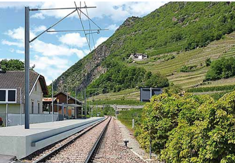
Ab 2019 werden ca. 1.500 Masten für die Oberleitung errichtet (Rendering: STA)
